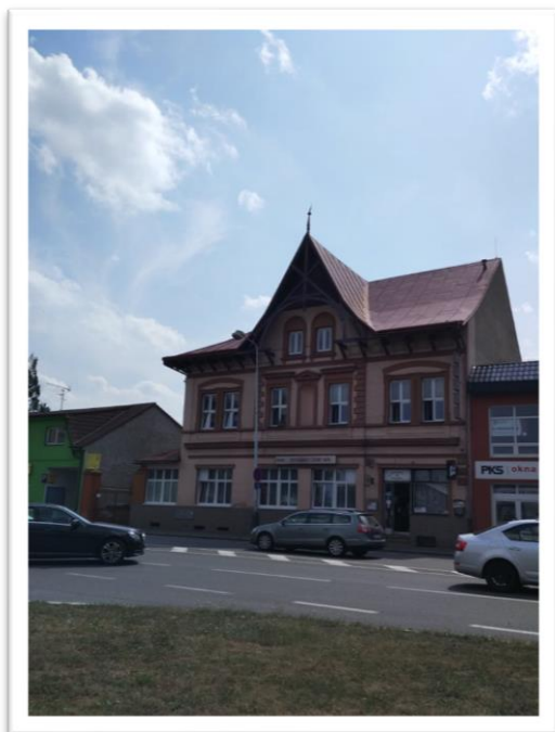
ubytovna "Černý kůň"
